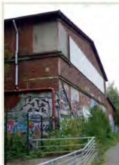
Opernfundushalle / Blick von Norden
