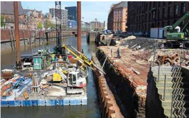
Kurzfristige Sanierungsarbeiten an der Kaimauer am Zollkanal und Maßnahmen an den Fundamenten der Speicherstadt
